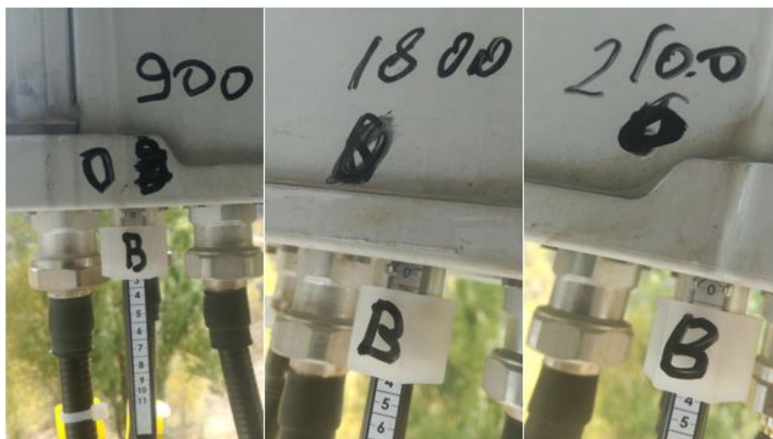
Рисунок 2- Установка тилтов на секторе 2 (В)
